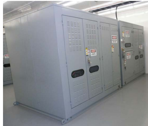
WCS Indoor CAP banks (2 banks)
