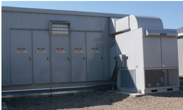
WCS HVAC and Fan Units
